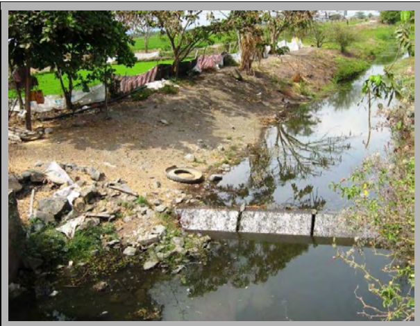
Foto 9. Canal de drenaje del distrito de riego América. 22 OCT 2009. PFF.
