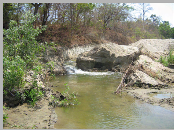
Foto 7. Vertedero del embalse formado en el río Colimes. 15 SEP 2009. PFF.
