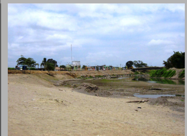
Foto No. 21. Al fondo, puente sobre el río Bulubulu que une la población de Taura con la vía Taura - Km 26.
