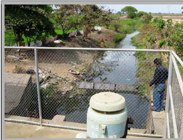
Foto 8. Canal de drenaje del distrito de riego América. 22 OCT 2009. PFF.
