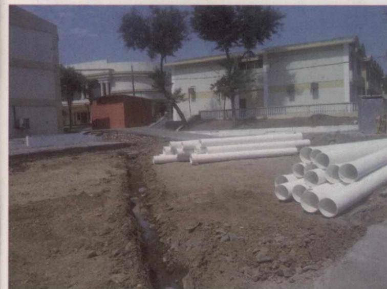
Foto izq.: Colocación de tuberías para drenaje de aguas lluvias en sede principal.
